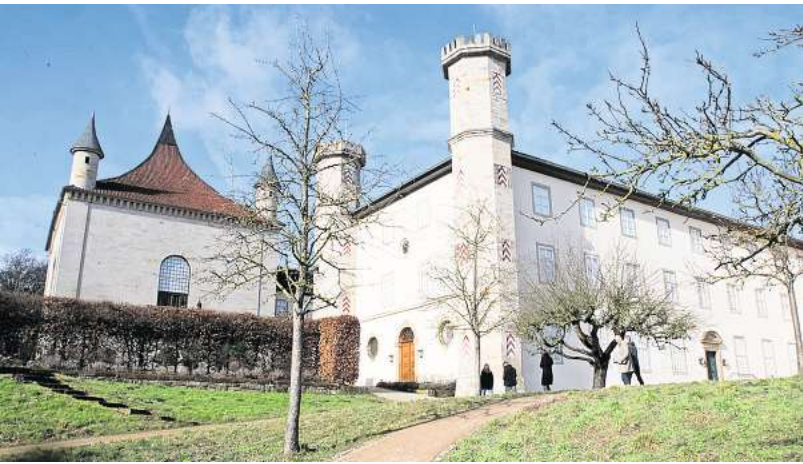
Das Kunstmuseum Schloss Derneburg hat ab Sonntag wieder geöffnet. Hier ein Blick auf den Ostflügel – der Nordflügel wird aktuell saniert.
