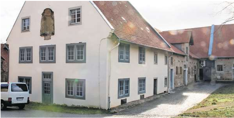
Von außen macht die Alte Meierei einen guten Eindruck. Doch die Fenster sind nicht echt, sondern für die Zeit der Sanierung nur bedruckte Folien.
